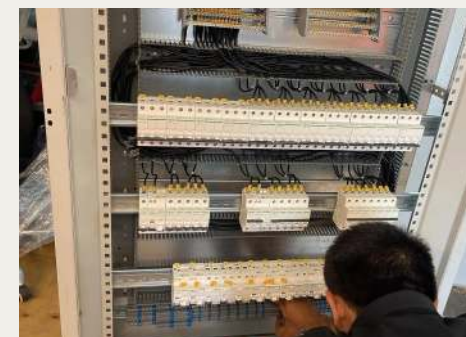
PANO · ELEKTRİK MONTAJI
